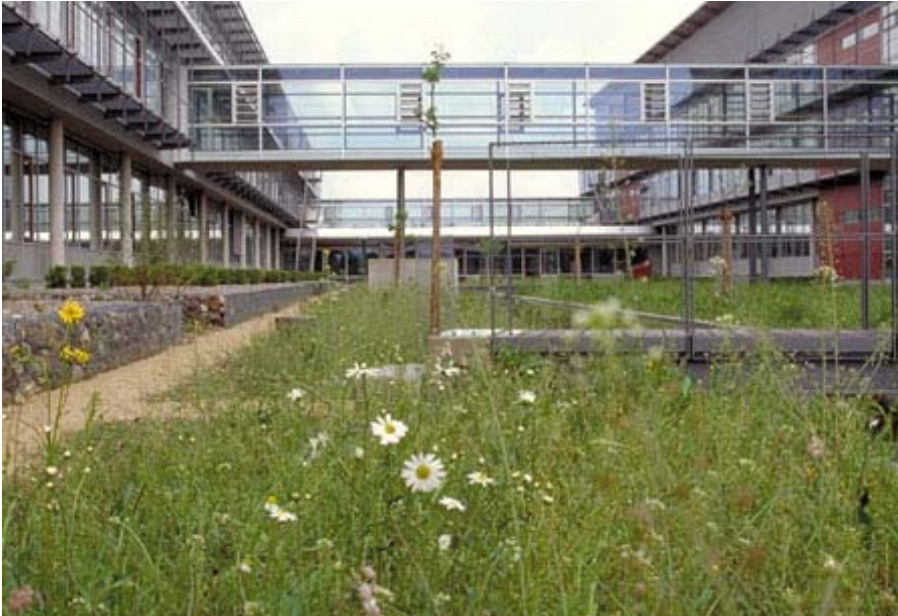
Foto 1: Innenhof zwischen mittlerem und Südflügel, Blick nach Osten. Für Vögel erscheinen der durchsichtige Übergang und der verglaste Durchgang hinten nicht als Hindernisse.
