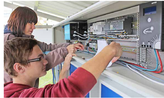
Installation der Elektrotechnik
