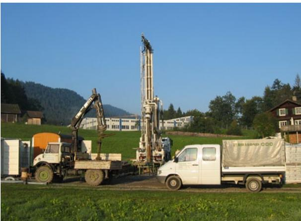
Bohranlage mit Begleitfahrzeug beim Abteufen einer Brunnenbohrung zur Trinkwasserversorgung
